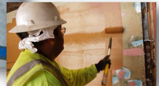
Roll on Fluid-Applied
